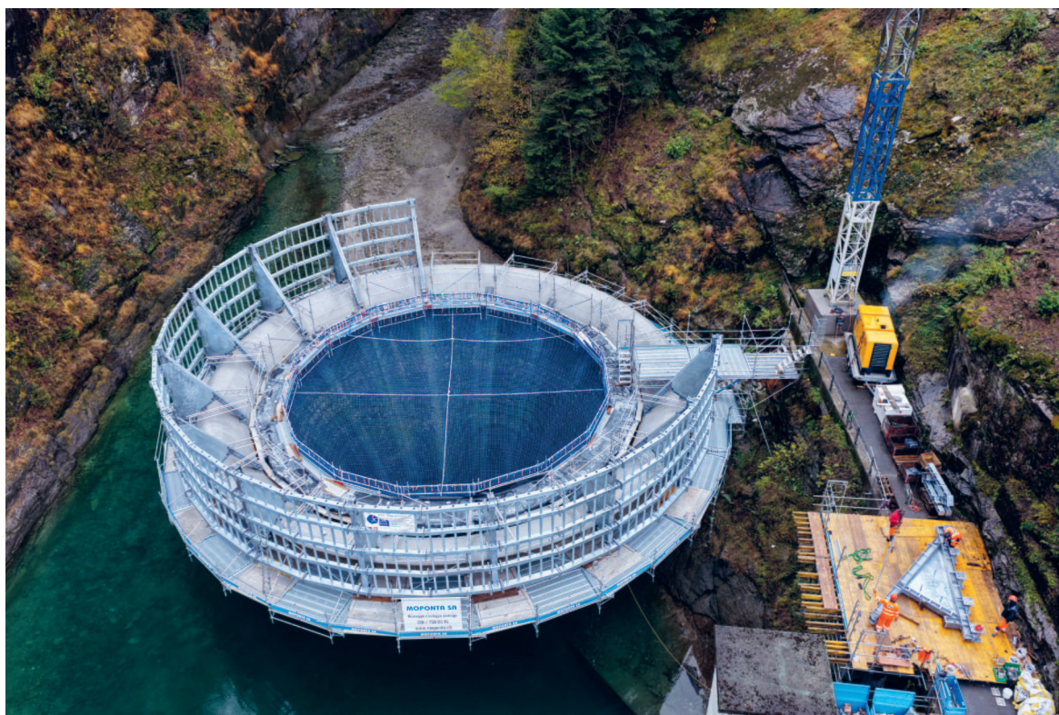
Bild 3 Montage des Makrorechens am Überlauf (oberer Durchmesser: 26 m).
