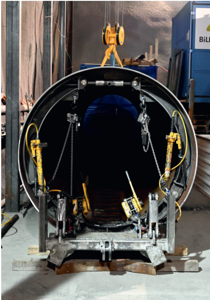
Neues Druckrohrstück mit Druckmanschette.
