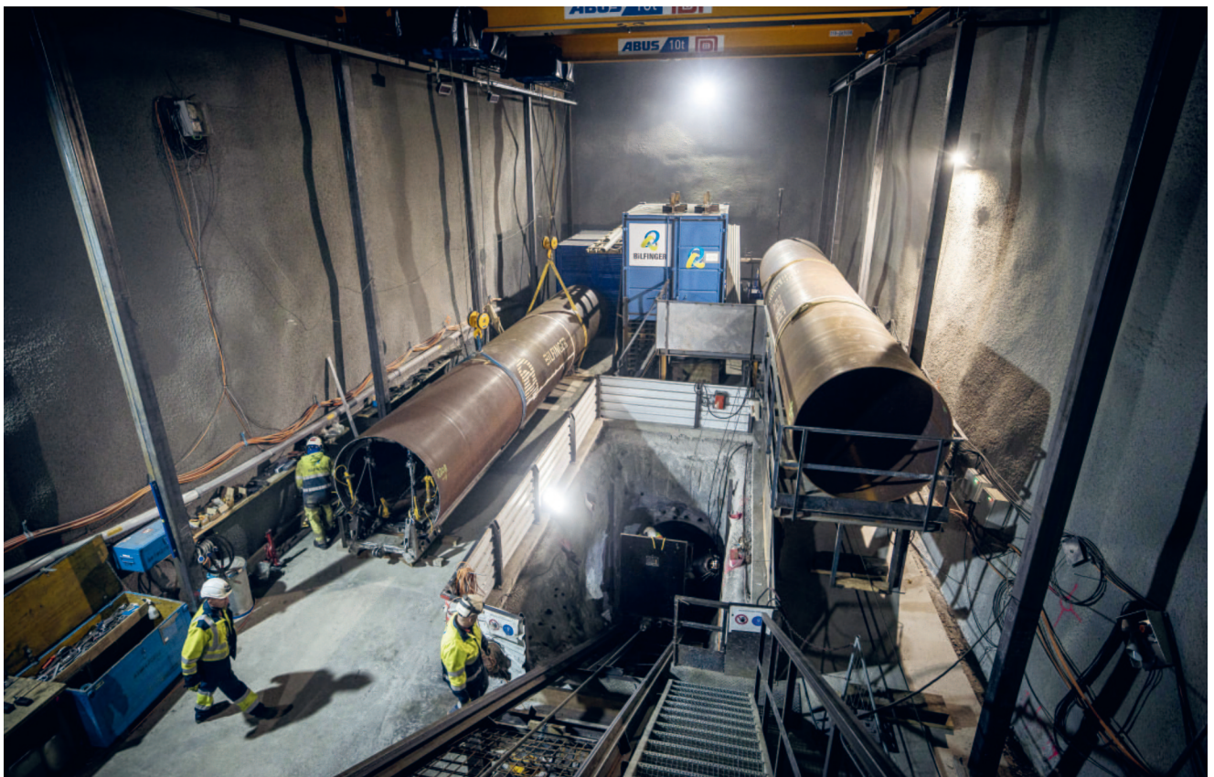
Neu erstellte Kaverne in der Mitte des Druckschachts.
