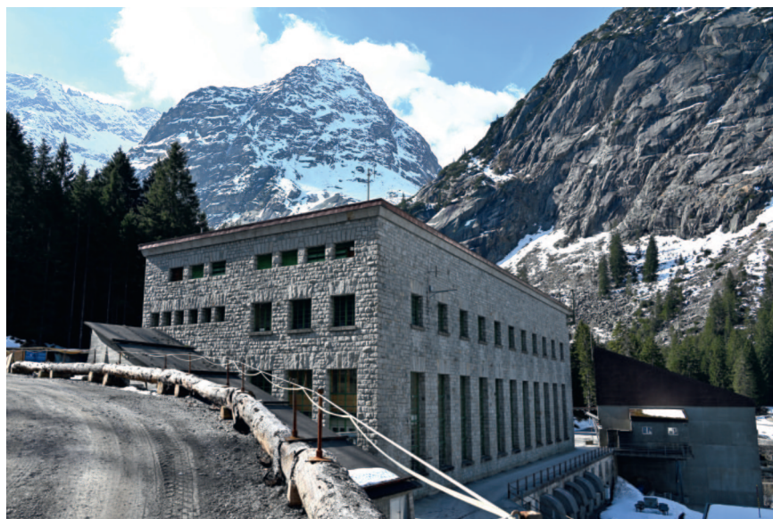
Das Kraftwerk Handeck mit der neu für die Sanierungsarbeiten gebauten Transportstrasse links.
