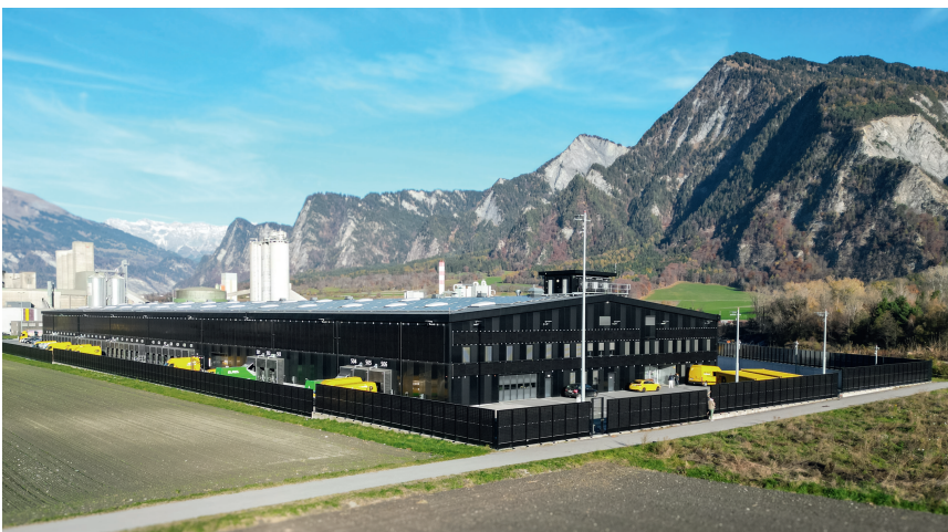
Vertikale Solaranlagen und Batteriespeicher von Enshift am Logistikzentrum Untervaz.
