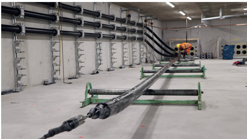
Bild 3 Die Verlegung eines Erdkabels.
