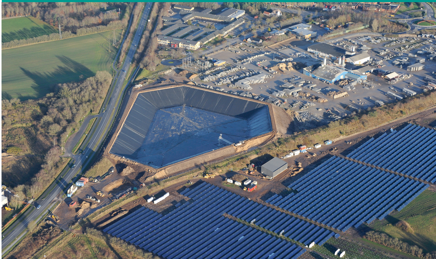
Le PTES de Vojens, au Danemark, combine panneaux solaires thermiques et stockage de chaleur.
