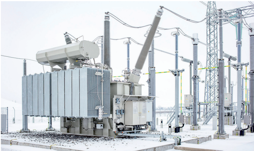
Bild 2 Beispiel eines ölgefüllten Fixed Shunt Reactors 72 Mvar, 400 kV.
