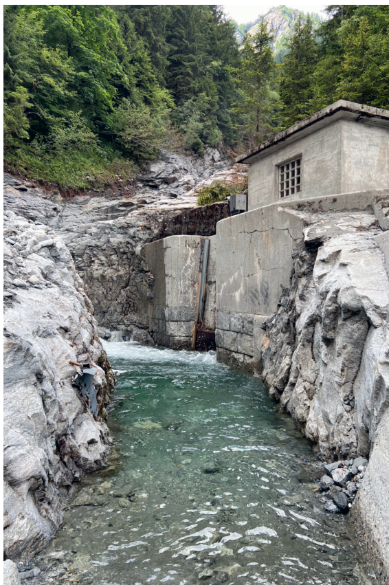
Die wieder geräumte Wasserversorgung von Soveneda.
