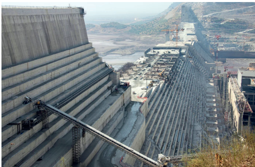
Die seit 2011 im Bau befindliche Grand-Ethiopian-Renaissance-Talsperre umfasst eine ca. 2 km lange und 145 m hohe Gewichtstaumauer. Der Bau soll 2028 abgeschlossen sein.
