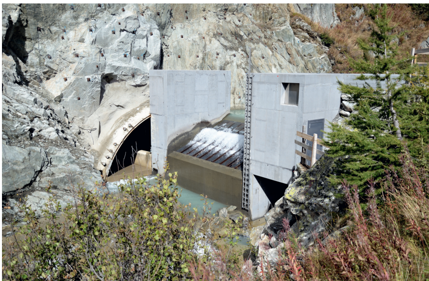
Fassung des hochalpinen Wasserkraftwerks Gletsch-Oberwald. Dieses Kraftwerk ist ein gutes Beispiel für eine konsensbasierte Kombination aus hydraulischer Energieerzeugung mit begleitenden Umweltmassnahmen, denn dank den Revitalisierungsmassnahmen erhielt die Rhone in Oberwald wieder ihren ursprünglichen Charakter.
