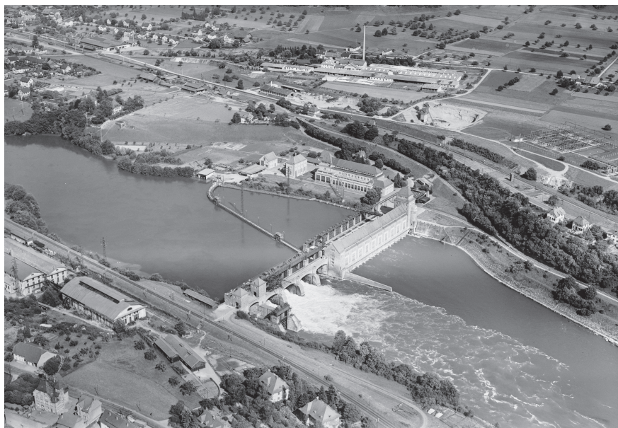
La centrale électrique de Laufenburg en 1953, cinq ans avant la création de l'« étoile de Laufenburg », qui est à l'origine du réseau interconnecté de l'Europe continentale.
