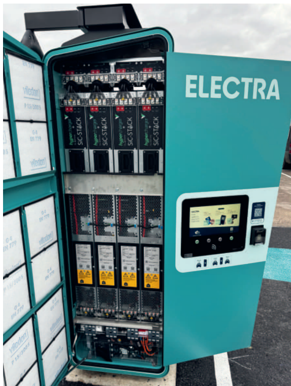
Bild 3 Alpitronic-Schnell-ladesäule mit vier Stacks.
