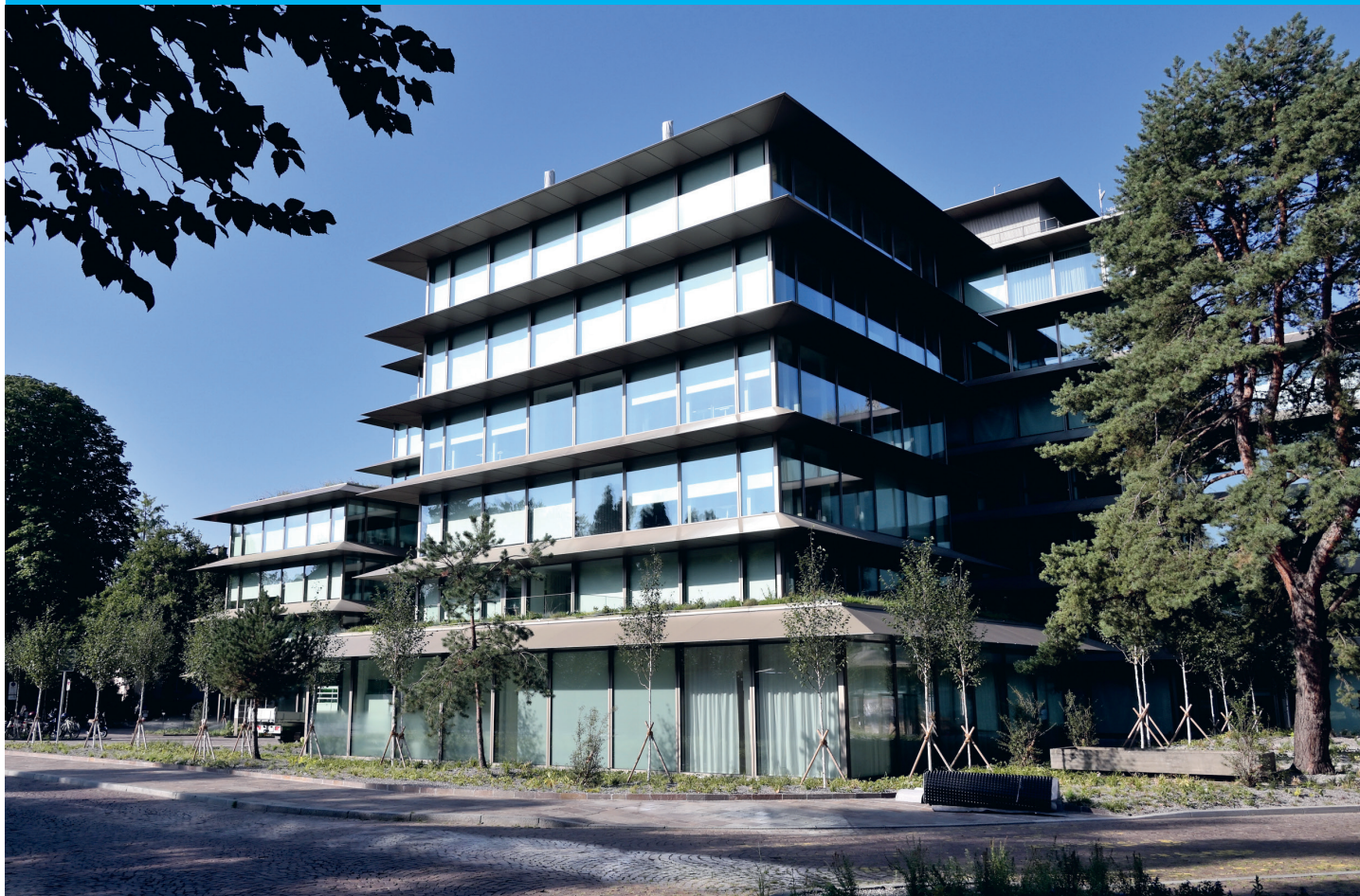
Das sanierte Geschäftshaus an der Bellerivestrasse 36 in Zürich mit PV-Vordächern.
