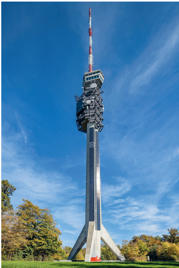
Vier Flächen des Turmschafts des 250 m hohen Sendeturms auf St. Christophona wurden 2017 mit PV-Modulen ausgestattet.
