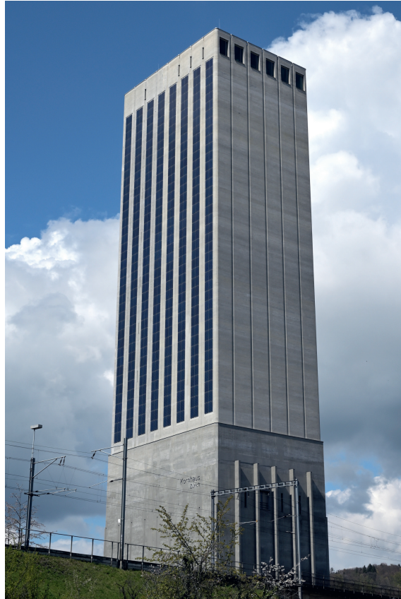
Die Südseite des Kornhauses im Zürcher Industriequartier ist mit Solarmodulen mit einer gesamten Nennleistung von 444 kW ausgerüstet. Reparaturen hinter den Panels stellen eine Herausforderung dar, da eine mobile Plattform nicht auf die nötige Höhe kommt.
