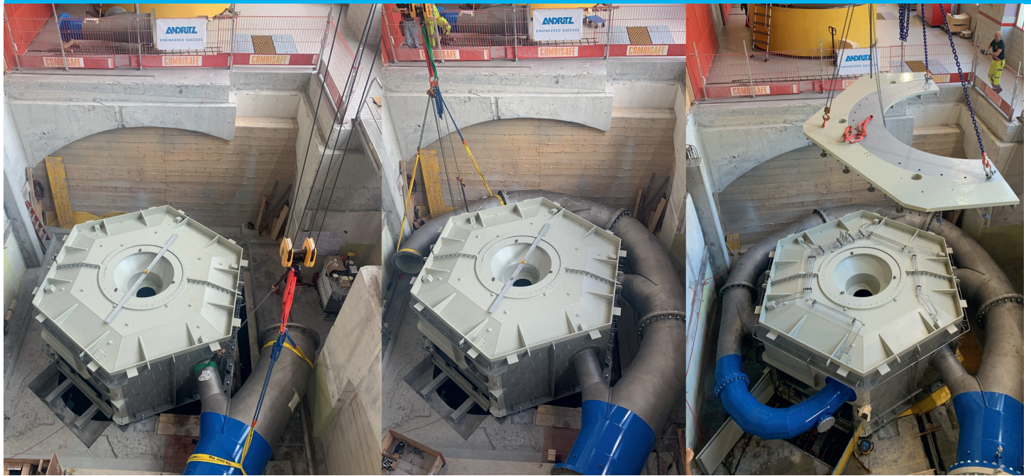
Nouvelle turbine Pelton de la centrale de Sembrancher en cours de montage dans le bâtiment existant.
