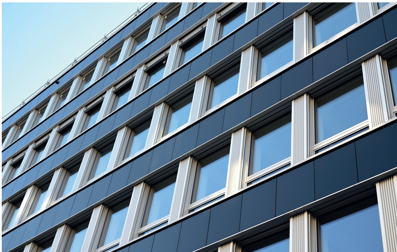
Eine Besichtigung zum Abschluss: Ohne die Erscheinung zu ändern, wurde aus einem 1960er-Gebäude ein stromerzeugendes Haus.
