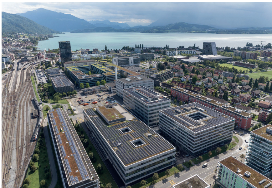
PV-Anlagen auf dem Siemens-Campus in Zug.
