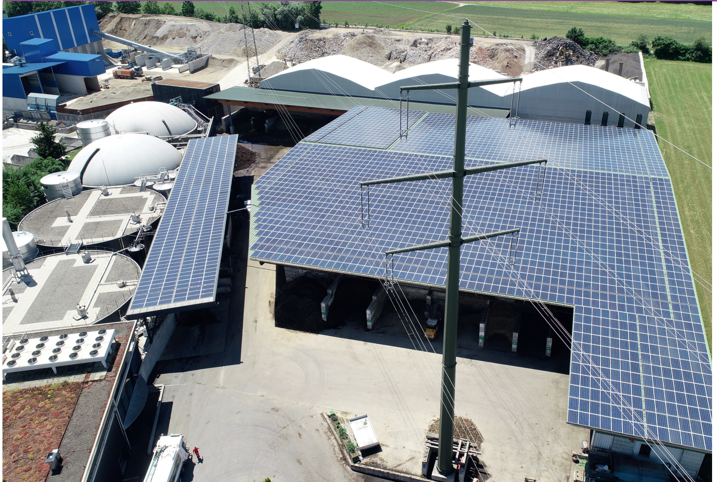
Eine PV-Anlage im Netz der AEW, bei der die Blindleistung geregelt wird, um das Netz zu stabilisieren.
