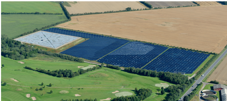
Bild 2 Erdbeckenspeicher in Tofund, Dänemark [5].
