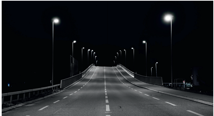
Bild 1 Neue Beleuchtung einer Hauptstrasse in Delémont.
