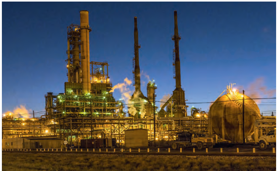
In Grossanlagen wie Raffinerien kann der Ausfall eines Anlagenteils die ganze Produktion lahmlegen. Die hohen Kostenfolgen rechtfertigen auch entsprechend hohe Investitionen in die Predictive Maintenance.
