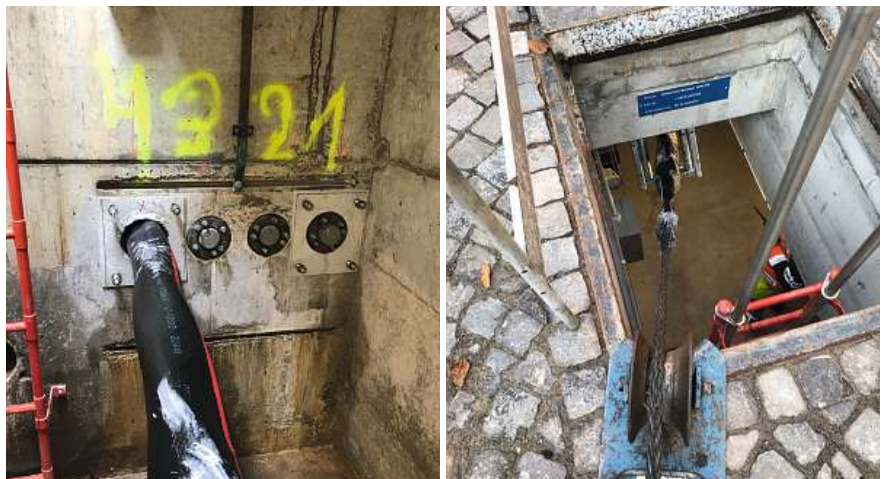
Bild 1 Eingezogenes 150-kV-Dreileiterkabel in bestehendem Kabelschutzrohr durch Muffenschacht.
