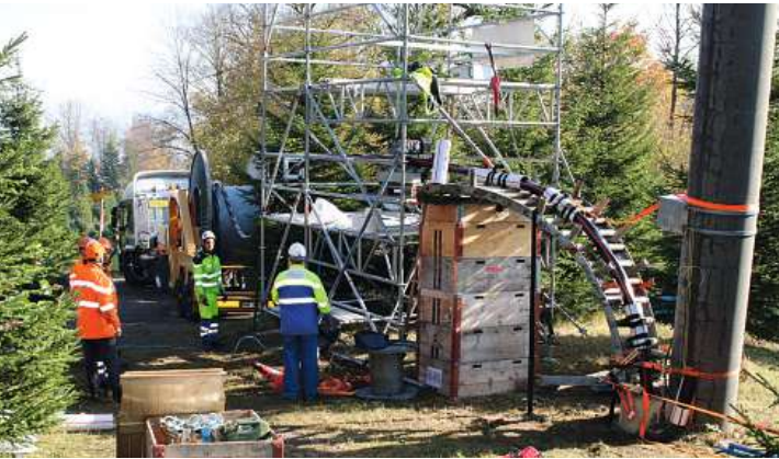
Bild 5 Kabeleinzug des neuen Typs in Zürich zwischen November 2017 und März 2018.
