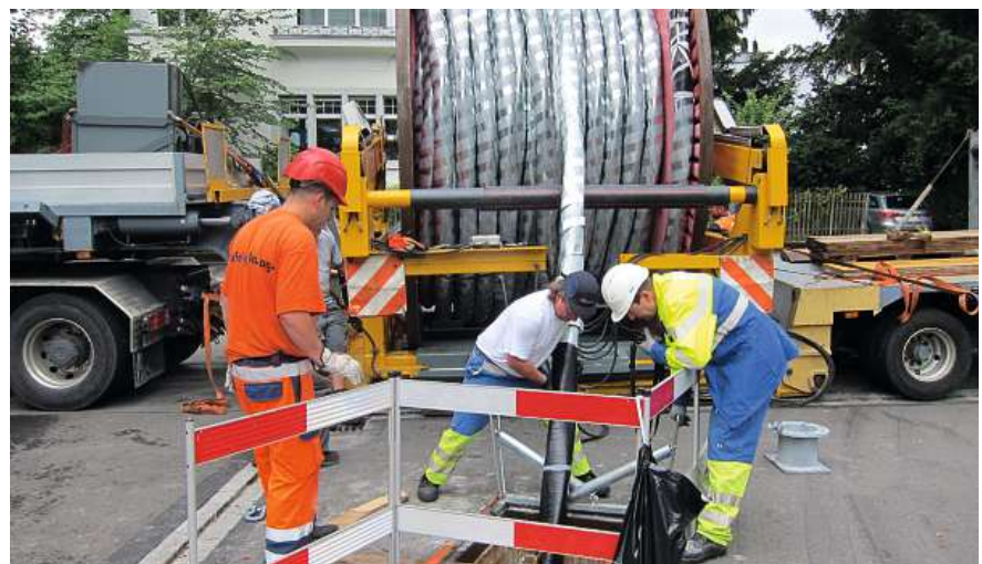
Bild 4 Kabeleinzug des ersten 150-kV-Dreileiterkabels im Jahr 2014.
