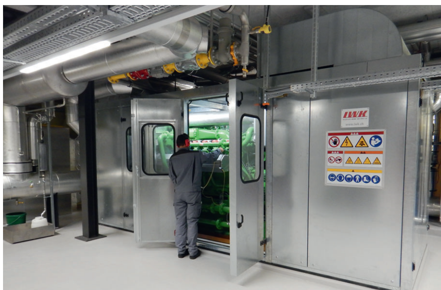
Figure 4 La centrale de cogénération de la station d'épuration Morgental de Steinach (SG) produit de l'énergie électrique à partir des gaz d'épuration. La station d'épuration fait partie du pool d'énergie de réglage d'Alpiq.
