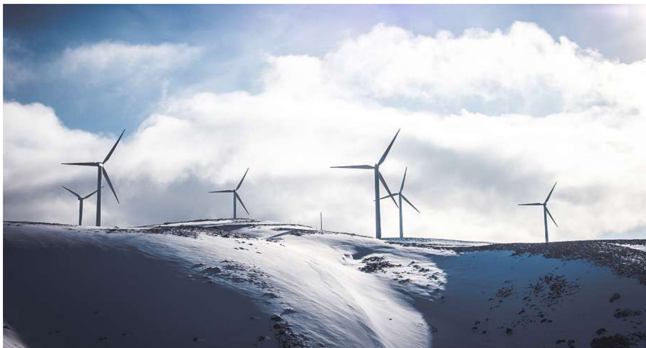
Parc éolien en altitude.
