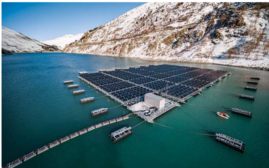
Installations photovoltaïques sur le lac des Toules.
