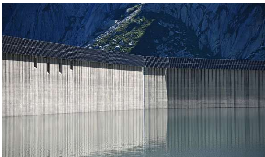
Barrage de l'Albigna.
