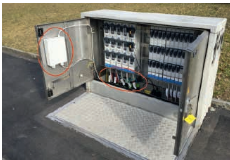
Bild 1 Installation von GridBox und Stromsensoren in einer Verteilkabine.
