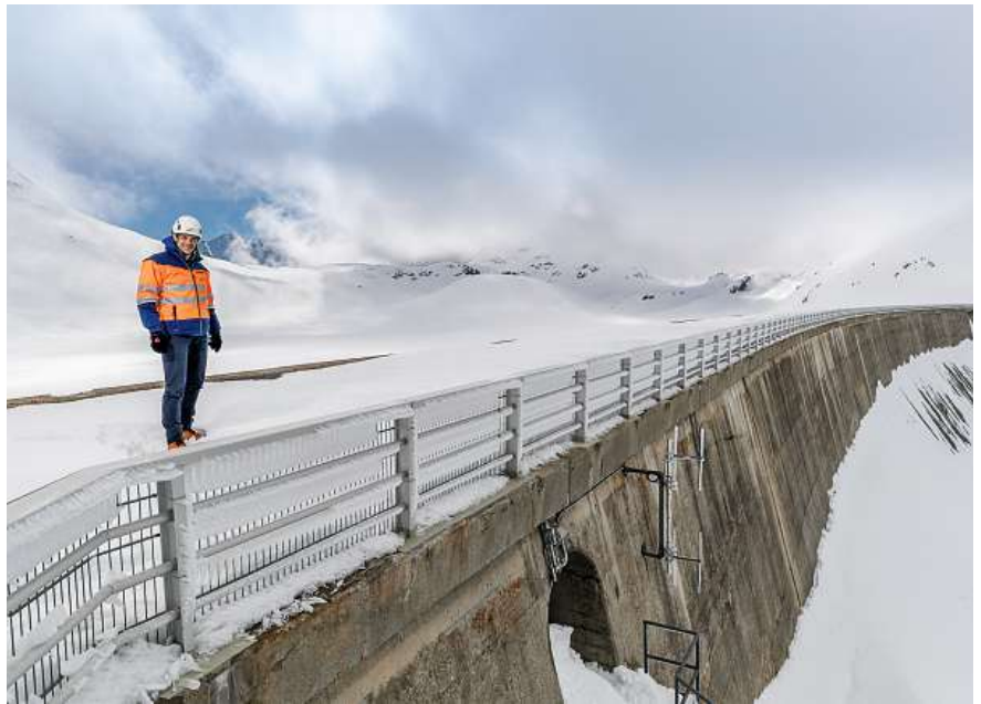
Die Staumauer Gries in Oberwallis.
