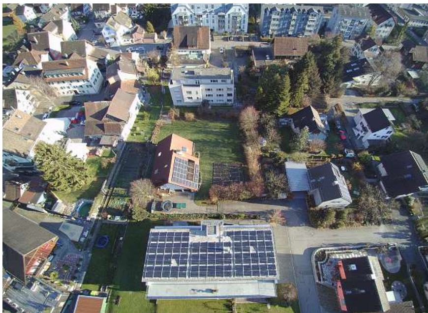
« Quartierstrom » est un projet pionnier dans le domaine du « marché local de l'électricité », mené depuis 2019 dans la commune saint-galloise de Walenstadt.
