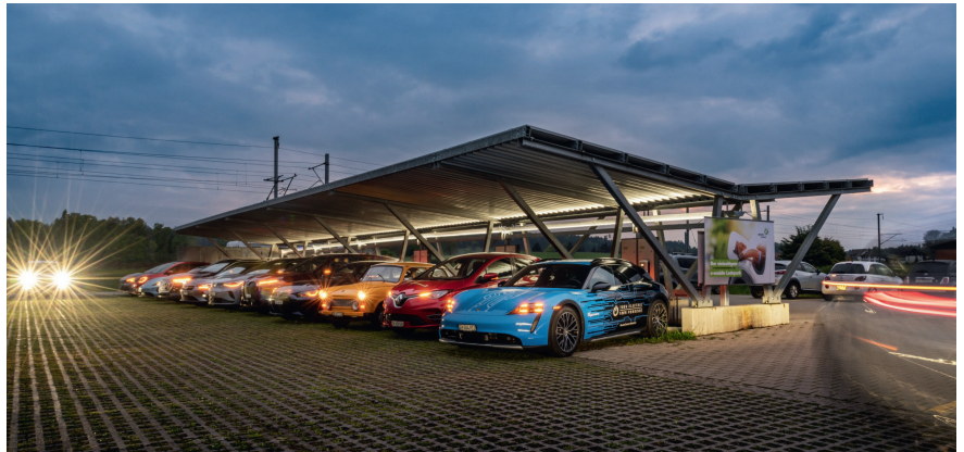
Der neue Ladepark an der Luppmenstrasse in Fehraltorf.
