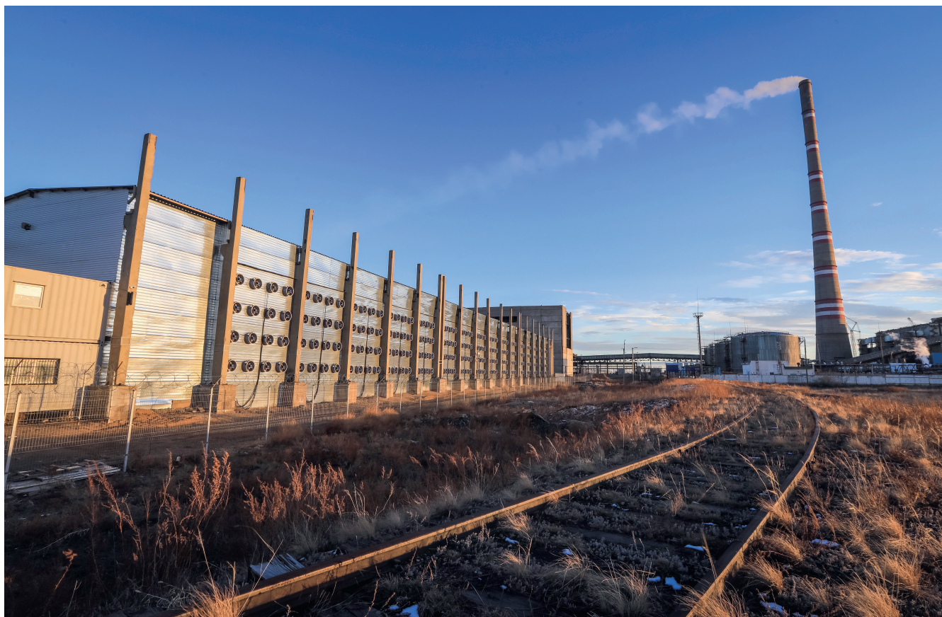
Kryptowährungs-Rechenzentrum neben einem Kohlekraftwerk in Kasachstan.
