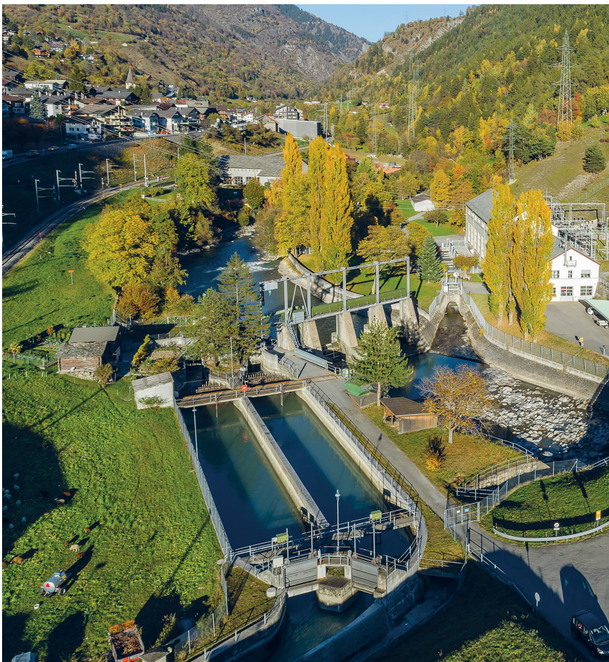
Figure 4 Dans la centrale au fil de l'eau à haute pression d'Ernen, dans le Haut-Valais, le remplacement de l'ancienne turbine Francis par une turbine Pelton est en cours d'essai afin d'acquérir de l'expérience pour des mesures de réaménagement.
