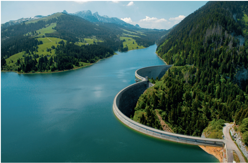
Figure 3 Le lac de retenue de l'Hongrin exploité par la centrale de pompage-turbinage vaudoise FMHL, au sein de laquelle est étudié le potentiel du fonctionnement en court-circuit hydraulique pour la mise à disposition d'une puissance de réglage négative sans palier.
