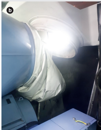
Figure 4 Exemples de défaillances détectées par l'algorithme : défaut sur la boîte de transmission (a) et tuyau de ventilation arraché (b).
