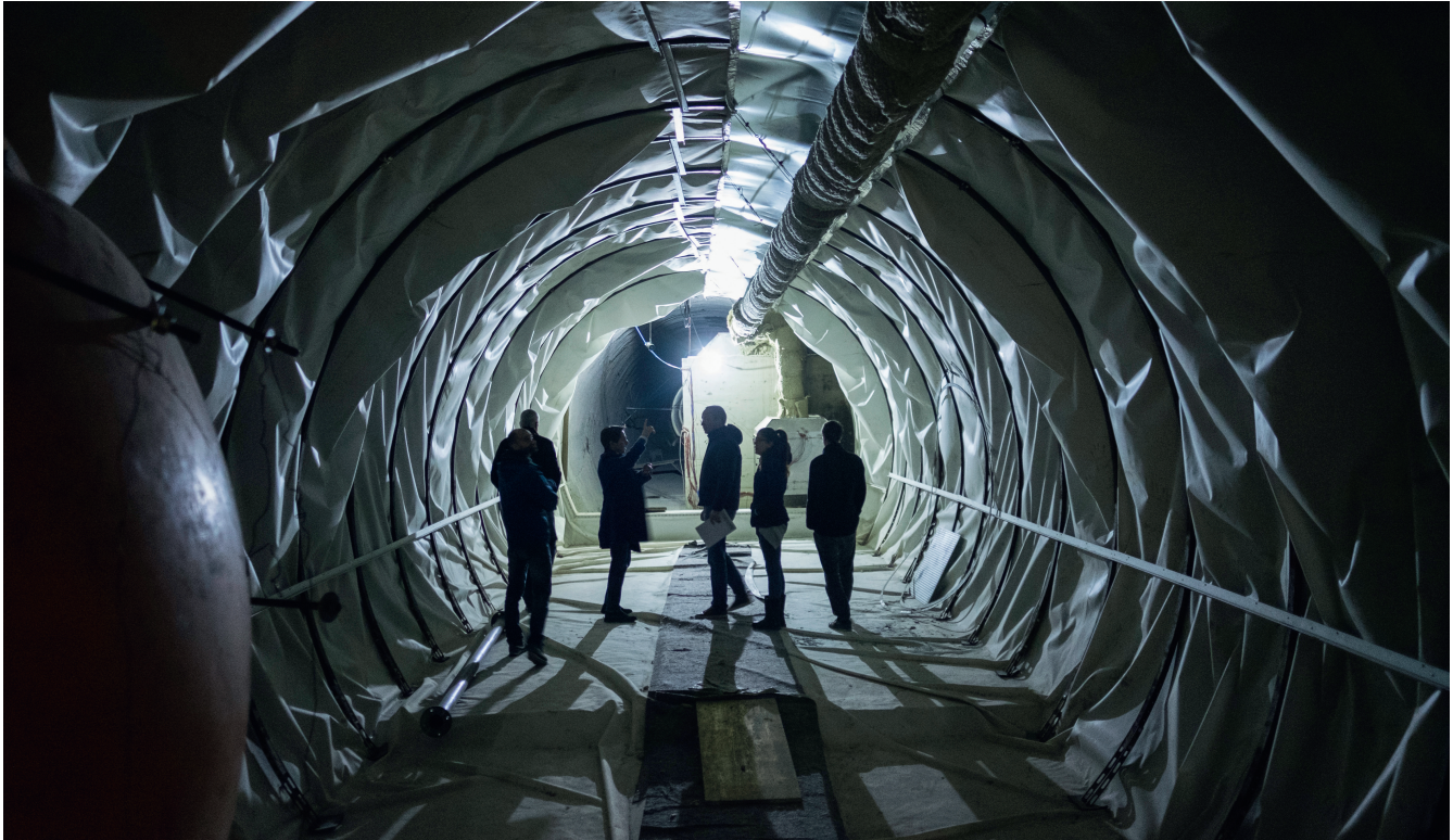
Speicherhohlraum in der Pilotanlage bei Pollegio.
