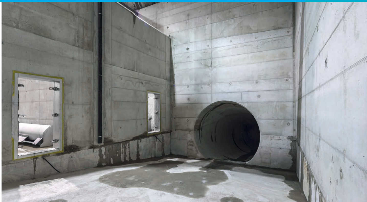
Druckaufbaukammer während des Baus.
