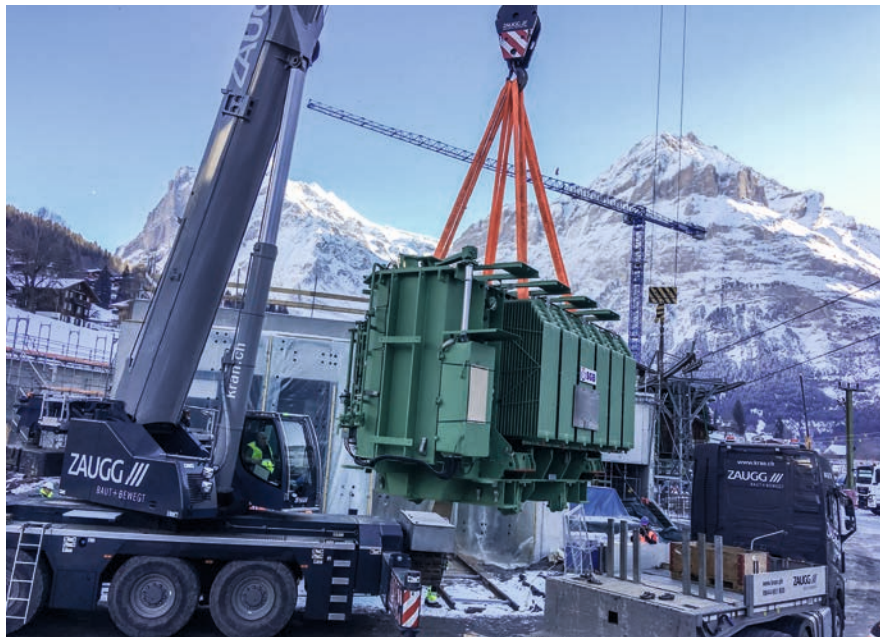
Bild 3 Anlieferung eines 25-MVA-Transformators in Grindelwald.
