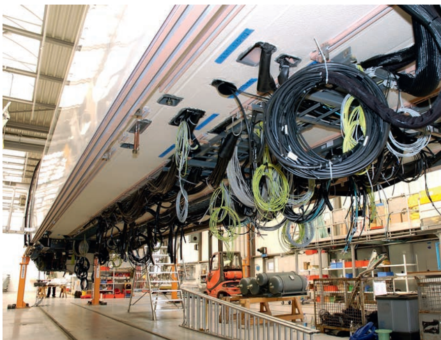
Bild 4 Kabelmenge in einem Zug.
