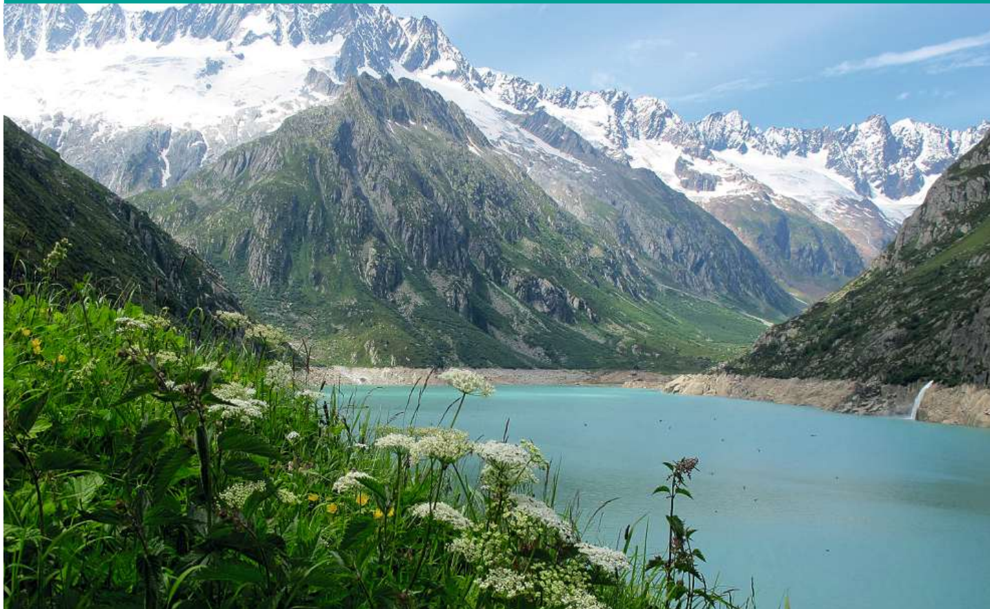
Die Wasserkraft (im Bild der Göscheneralp-Stausee) ist das Rückgrat der Energiestrategie 2050.
