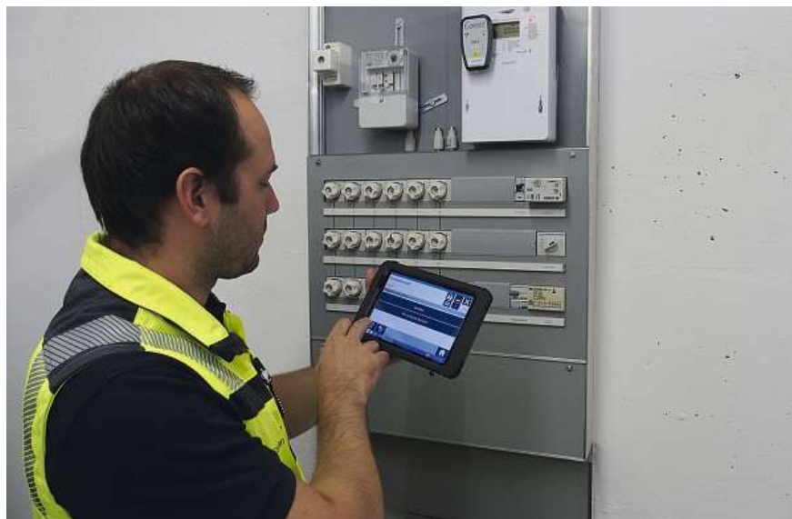
Bild 3 Ablesung des neuen Zählers via Bluetooth nach der Montage.
