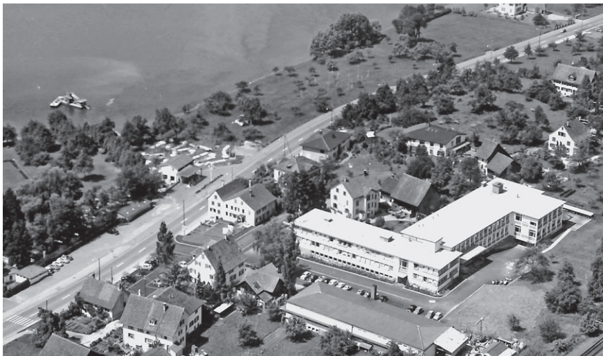
Bild 6 Neues Fabrikgebäude in Männedorf 1958.
