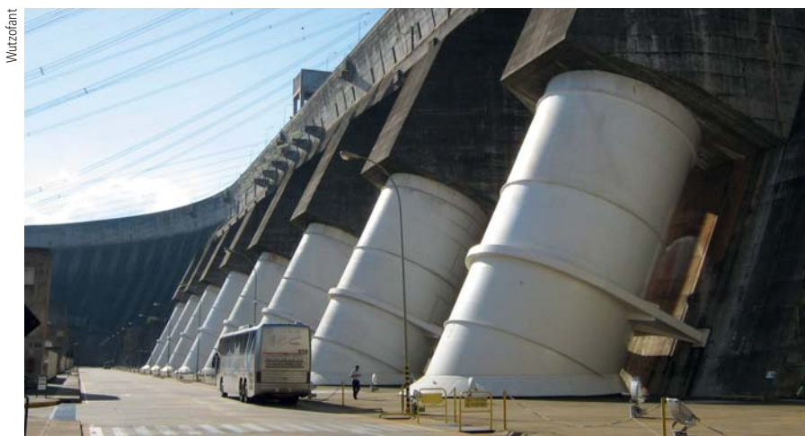
Bild 3 Fallrohre des Wasserkraftwerks von Itaipú. Selbst dieses gigantische Wasserkraftwerk kann die Wassermassen über grosse Teile des Jahres nicht voll verwerten.
