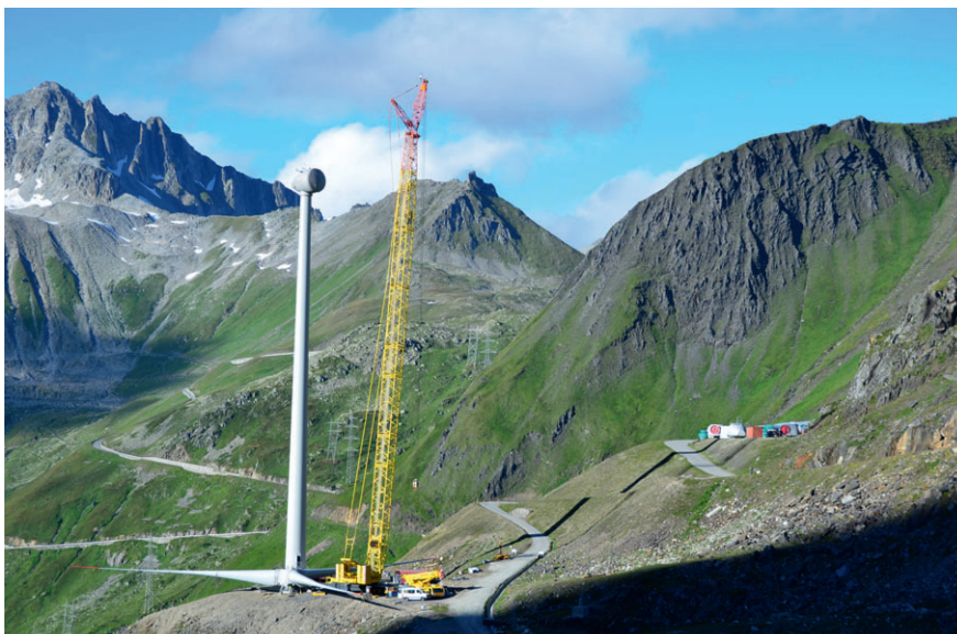
Bild 2 Vorbereitungen am Griespass für die Rotormontage auf einer der neuen Anlagen mit Nabenhöhe 131 m. Die engen Platzverhältnisse stellen dabei eine besondere Herausforderung dar. Im Hintergrund ist die Nufenenstrasse sichtbar.
