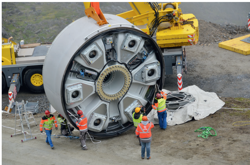
Bild 3 Bei den Griespass-Anlagen werden getriebelose Ringgeneratoren eingesetzt, die wartungsarm sind, da sie kaum Verschleisssteile aufweisen und der Getriebeölwechsel entfällt.
