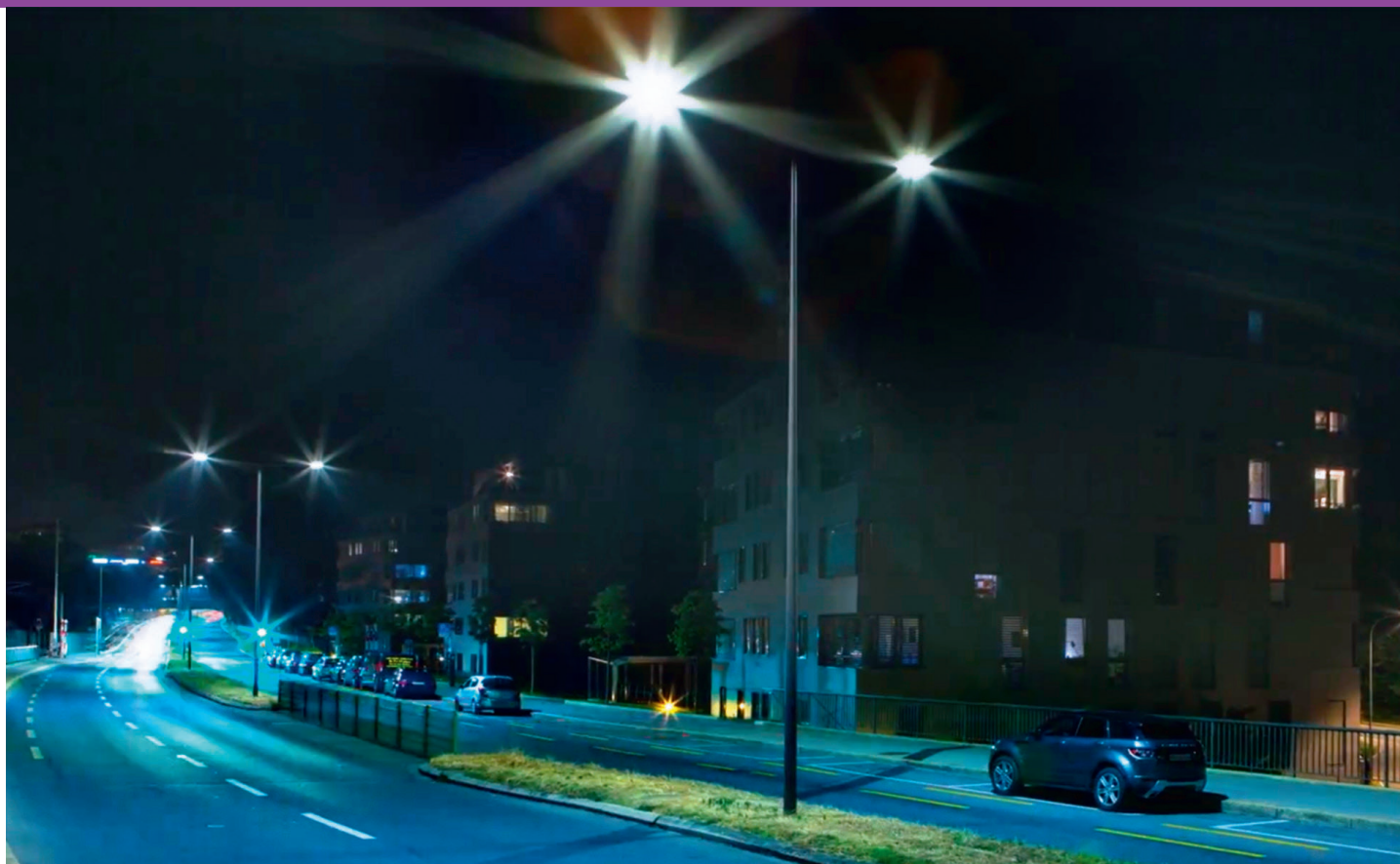
Figure 1 À Lausanne, 50 lampadaires de l'avenue de Provence sont dotés de capteurs intelligents. Ils permettent aux services industriels de la ville d'en contrôler l'intensité lumineuse à distance. [1]
