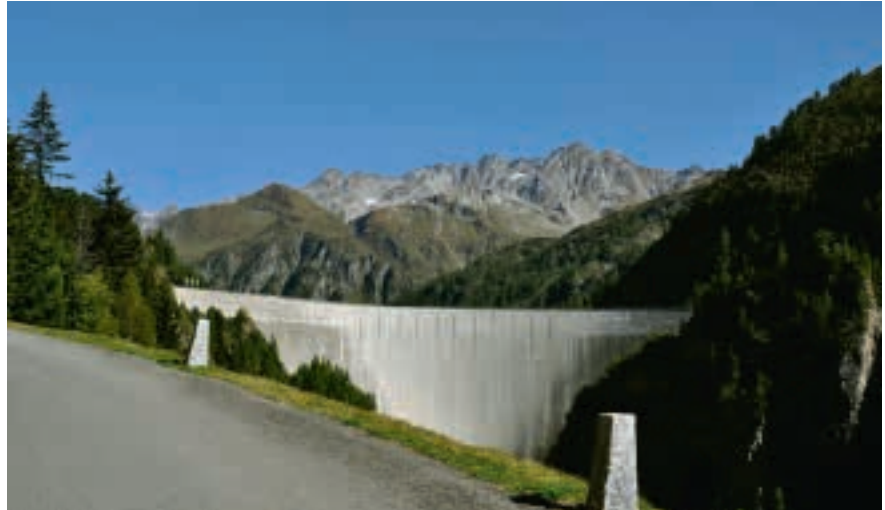
Le calcul de la redevance hydraulique fait l'objet d'une nouvelle réglementation (ici, le barrage de Luzzone, à Blenio).
