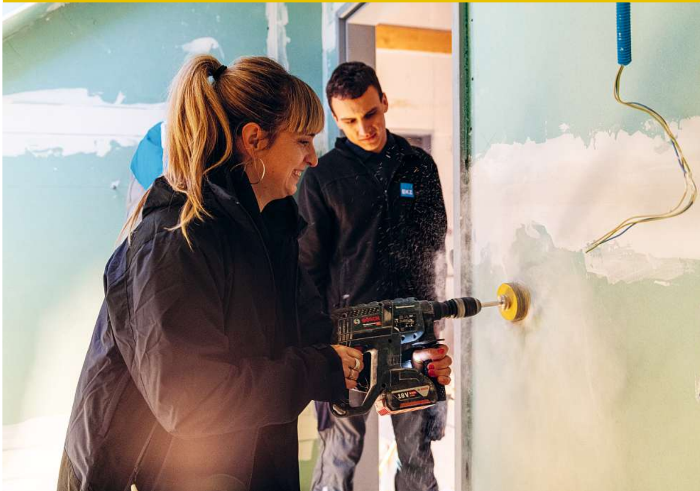
Elektroinstallateur Tim Steiger zeigt Sara Satir, wie man einen Kronenbohrer bedient.
