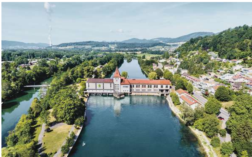
Das Kraftwerk, wie es sich heute präsentiert. Im Hintergrund ist das Ende des umstrittenen Mitteldamms erkennbar.
