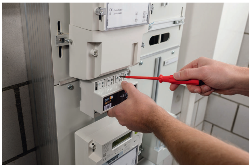
Bild 1 Die GridSense-Technologie steuert die Lasten so, dass das Verteilnetz möglichst optimal ausgelastet ist. Die GridSense-Unit wird zwischen den zu steuernden Gebäudetechnik-Geräten und der Stromzuleitung installiert.
