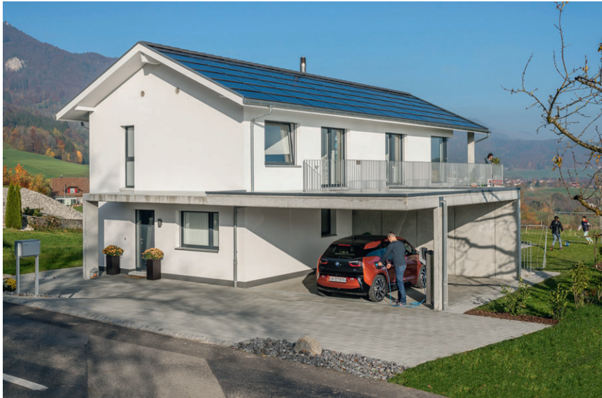
Bild 2 Eines der 40 Einfamilienhäuser im solothurnischen Riedholz, wo in einem Pilotversuch getestet wird, wie sich die Belastung des Verteilnetzes dank «kluger» Steuerung der Verbraucher optimieren lässt.
