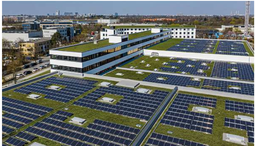
Auf dem Dach des Centro Tesoro ist die grösste innerstädtische PV-Anlage Münchens installiert. Mit einer Leistungskapazität von 428 kW produzieren 568 Paneele einen grossen Anteil des Mieterstroms.
