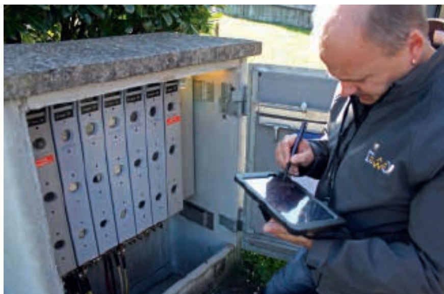
Bild 3 Die Kontrollresultate können direkt auf dem Tablet eingegeben werden. Der Umweg über das Papierformular entfällt - und damit auch der Medienbruch.
