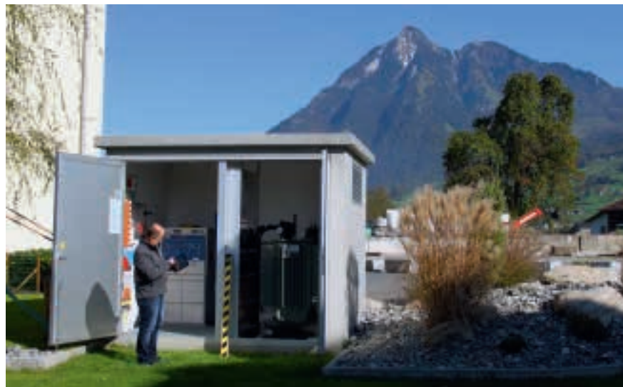
Bild 2 Inspektion einer Transformatorenstation mit Tablet.
