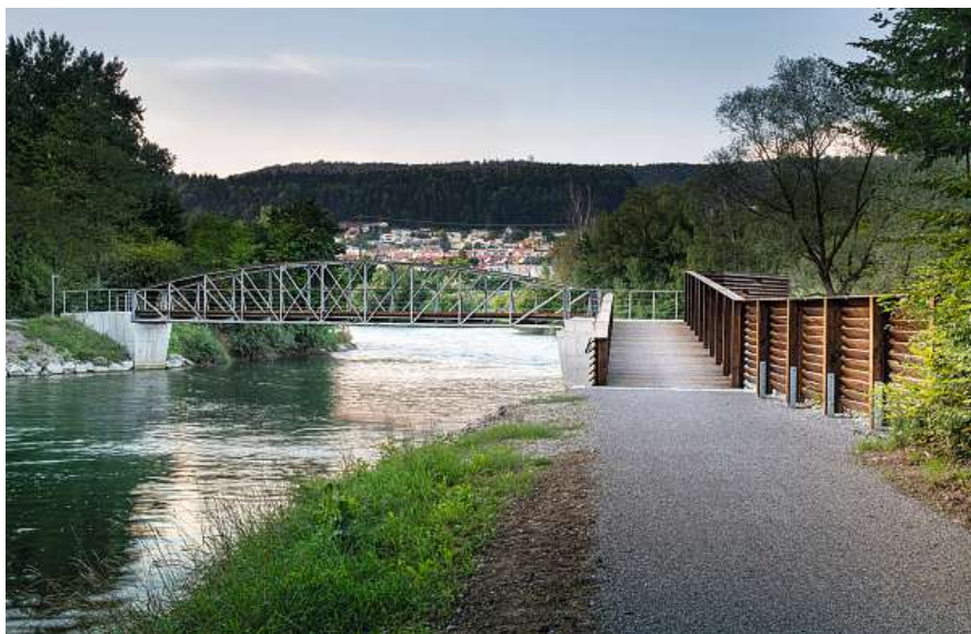
EKZ baute einen neuen Steg zur historischen Fachwerkbrücke, weil der Fussweg entlang der Limmat zugunsten des Naturschutzes aufgehoben wurde.
