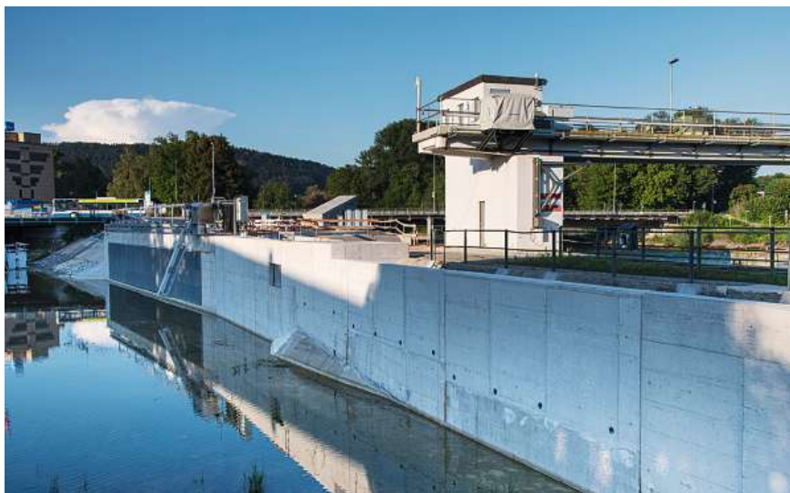
Das Dotierkraftwerk mit dem grossen fischfreundlichen Rechen.
