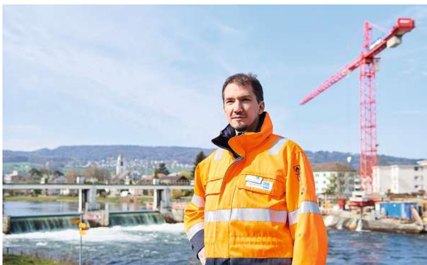
Projektleiter Alfredo Scherngell auf der Baustelle.
