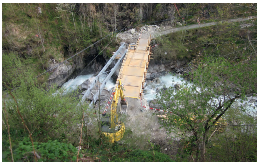
Bild 3 Das Verlegen der Druckrohrleitung in teilweise unwegsamem Gebiet ist eine beträchtliche bauliche Herausforderung.
