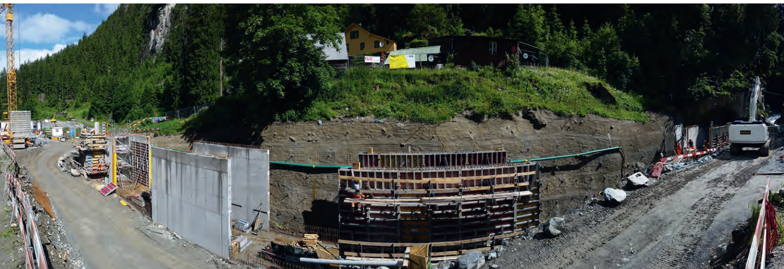
Bild 1 An der Baustelle im Maderanertal sind die Bauarbeiten derzeit in vollem Gang.
