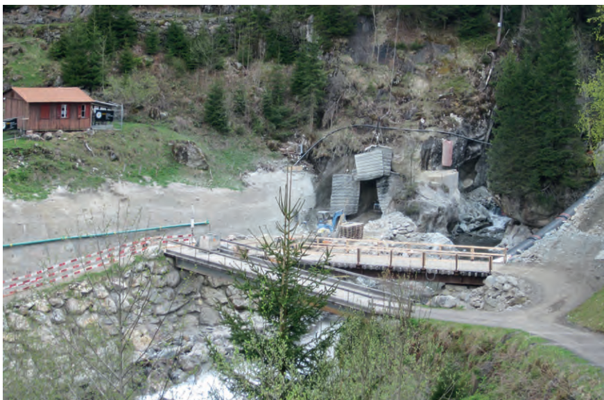
Bild 2 Blick auf die Baustelle der Wasserfassung, die hinter einem Fels versteckt werden wird.
